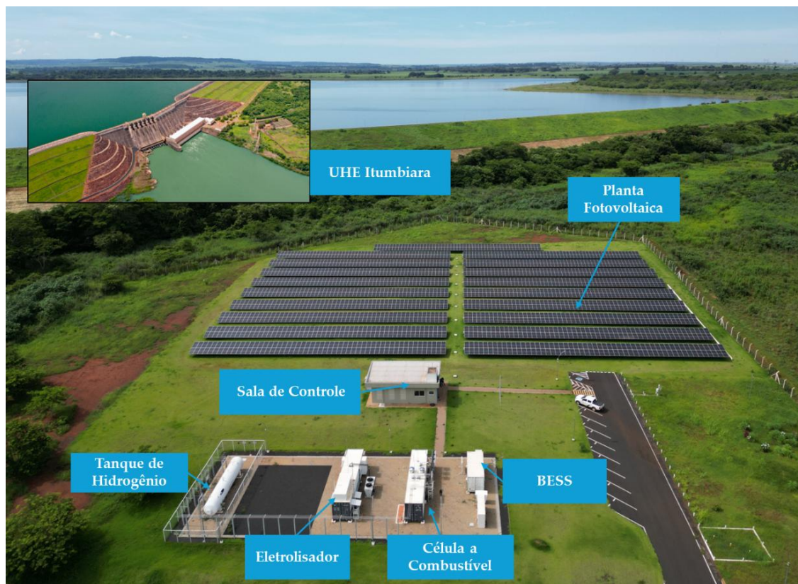
Figura 2.20 - Planta de hidrogênio renovável instalada na UHE Itumbiara Fonte: SOUZA RIEDEL (2024)
