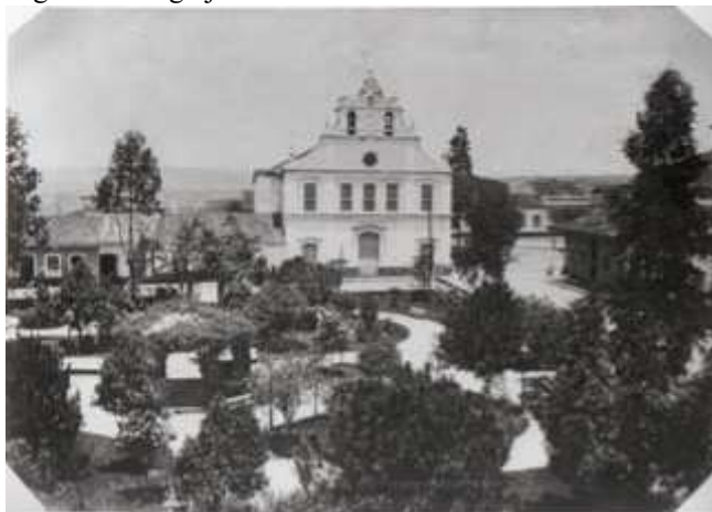
Figura 2.6 – Igreja N. S. dos Remédios
