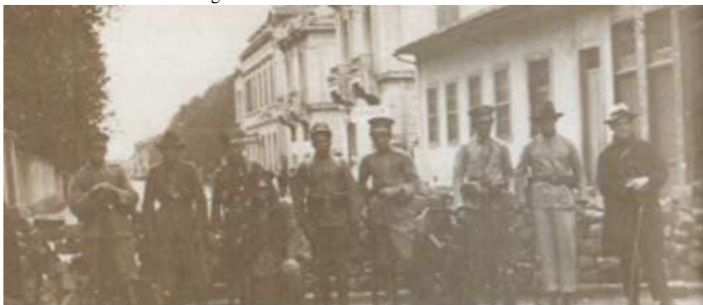
Figura 2.8 – Trincheira na rua Sete de Abril
