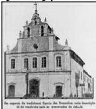
Figura 2.7 – Igreja dos Remédios
