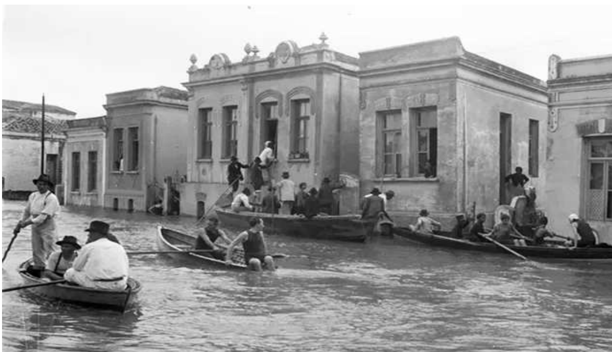
Imagem 2 – Pessoas enfrentam enchente do Rio Tamanduaté, afluente do Tietê, no bairro do Bom Retiro (início do séc. XX)
