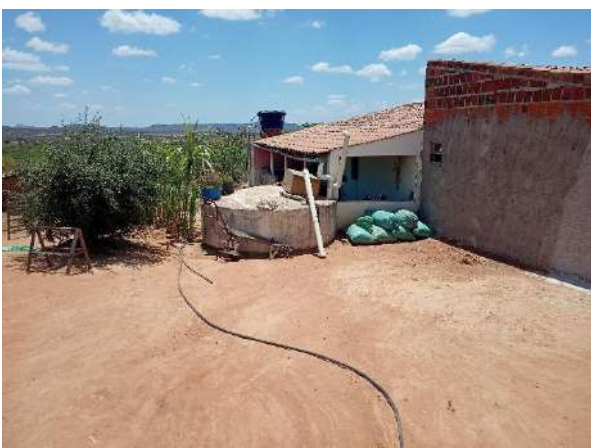
Imagem 34: Cisterna de placa de cimento de 16 mil litros
