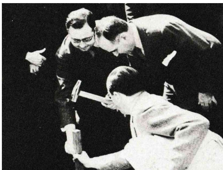
Imagem 18 – Getúlio Vargas lança a construção da Ponte das Bandeiras martelando a primeira estaca
