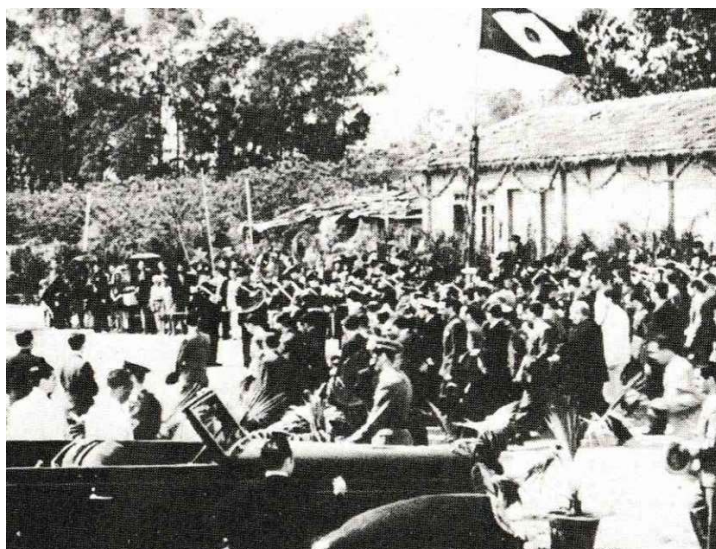
Imagem 19 – Multidão assiste ao lançamento da Ponte das Bandeiras
