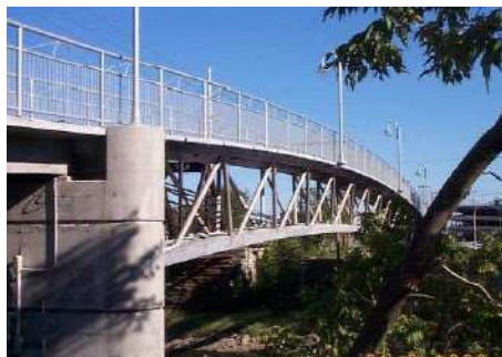
Figura 3: Ponte para pedestres e ciclistas construída com CUADRF em Sherbrooke, (AFGC, 2013)
