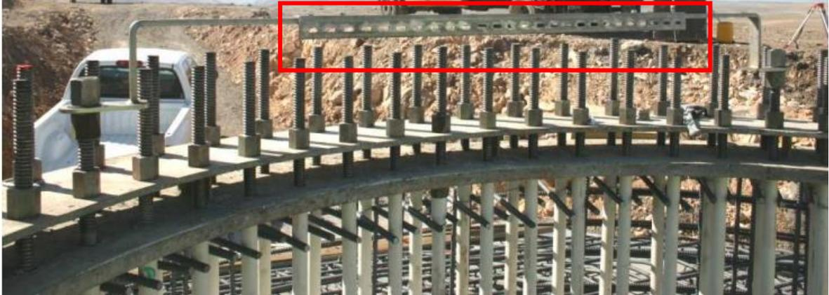
Figura 2.7 – Barra de equipotencialização principal do aerogerador, indicada em vermelho, Fonte: Catálogo Vestas.
