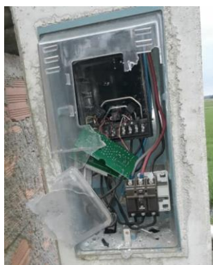
Figura 2.2: Medidor danificado propositalmente, extraído de [35].
