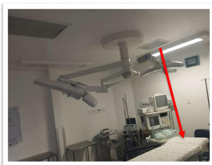
Figura 22. Foto da Sala de Parto com a saída do ar condicionado posicionada diretamente sobre a cama de parto (representação pela seta vermelha). Foto e intervenção: autor.
