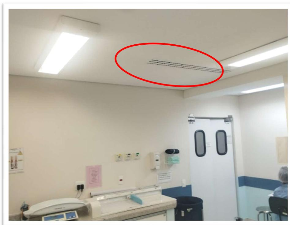
Figura 24. Grelha de saída do ar condicionado na Sala de Assistência ao Recém Nascido.
