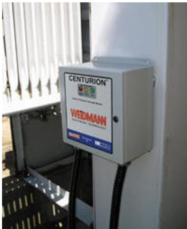
Figura 23 - Monitor de qualidade do óleo Weidmann Centurion
