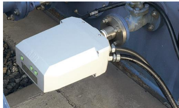
Figura 27 - Monitores de gás chave - MR/MESSKO e ABB
