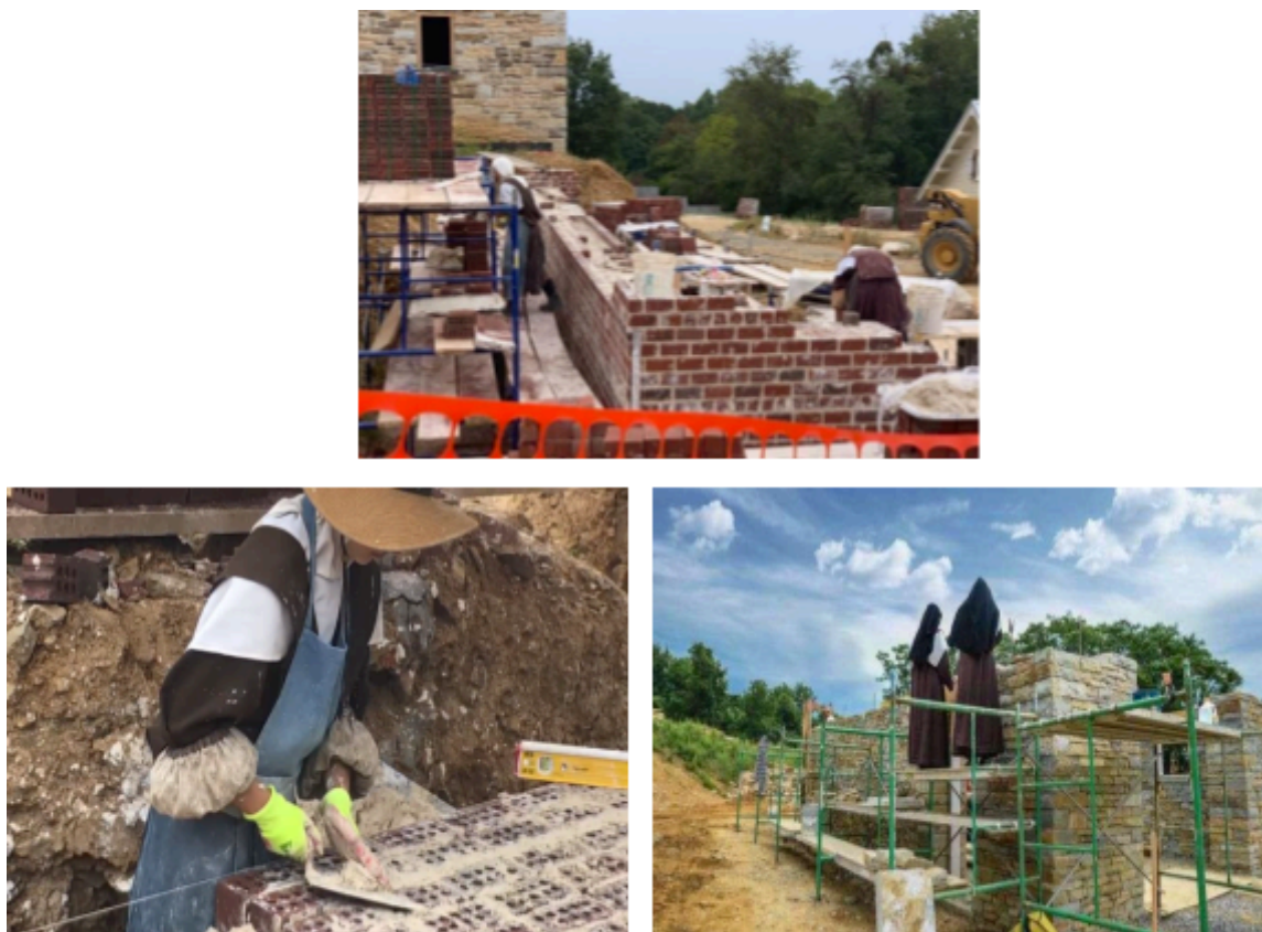
Figura 4 — Irmãs construindo o convento de Fairfield, no estado da Pensilvânia, nos Estados Unidos
