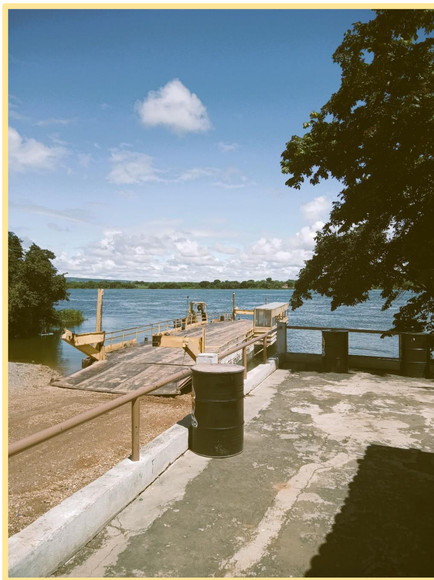
Balsa que realiza a travessia do Rio São Francisco e conecta os municípios de Santa Maria da Boa Vista (PE) e Curaçá (BA). Na margem de cá, Pernambuco. Do outro lado, Bahia. Imagem registrada pelo autor durante pesquisa de campo feita em dezembro de 2022.
