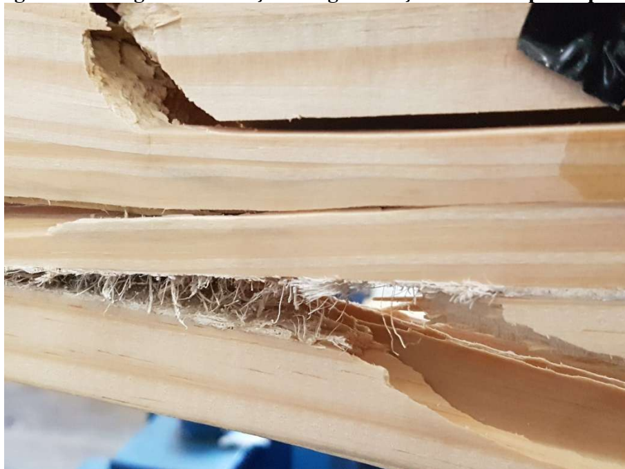
Figura 58 – Região do reforço da viga reforçada CUR2 após ruptura
