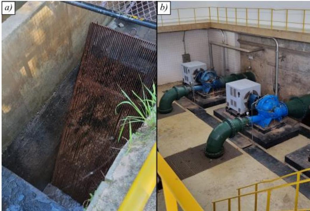
Figura 4 – Equipamentos da estação de captação. *a)* Grade de metal que impede a entrada de materiais grossos no tanque desarenador. *b)* Bombas hidráulicas para transporte da água.
