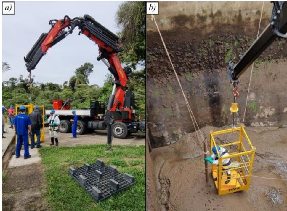
Figura 9 – Operação de içamento para coleta de sedimento do fundo do tanque. *a)* Caminhão do tipo guindauto posicionando a gaiola para entrada do funcionário. *b)* Inserção do tubo para coleta de testemunho de sedimento.
