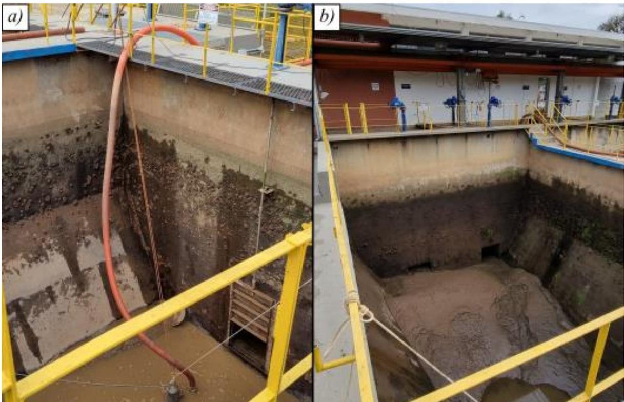
Figura 7 – Tanque desarenador da estação de captação de água. *a)* Sistema de sucção externo utilizado para remover a água abaixo do nível de captação das bombas. *b)* Forma das paredes do tanque, com sedimento acumulado ao fundo.
