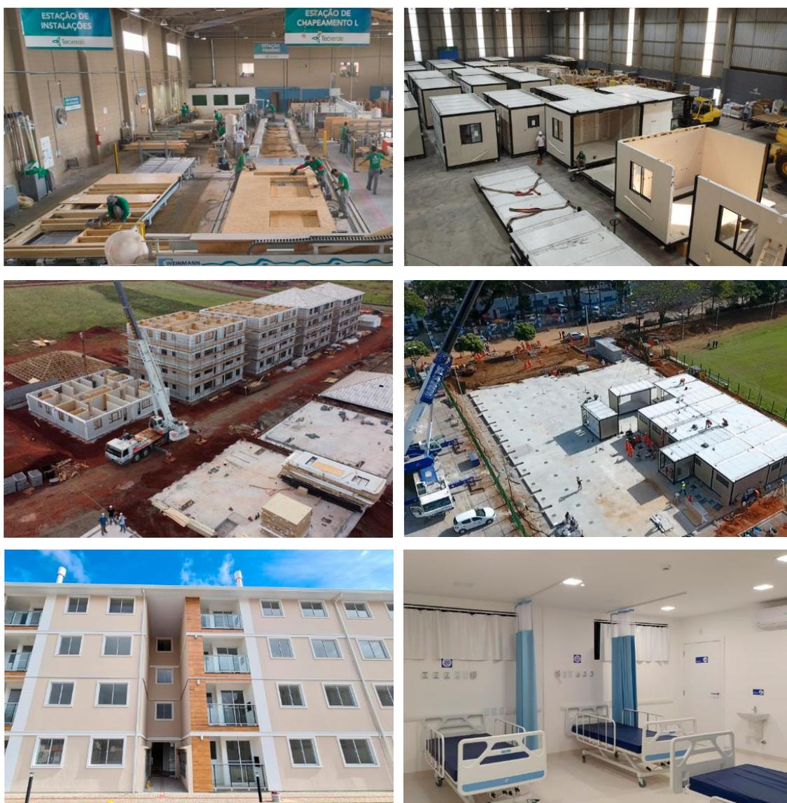
As imagens da esquerda mostram a produção em 2D dos painéis de WF, o canteiro de obras de um condomínio residencial e uma fachada finalizada. As imagens da direita mostram a produção dos módulos 3D, o canteiro de obras e a vista interna finalizada de um hospital. Fonte: Tecverde (2022b).
