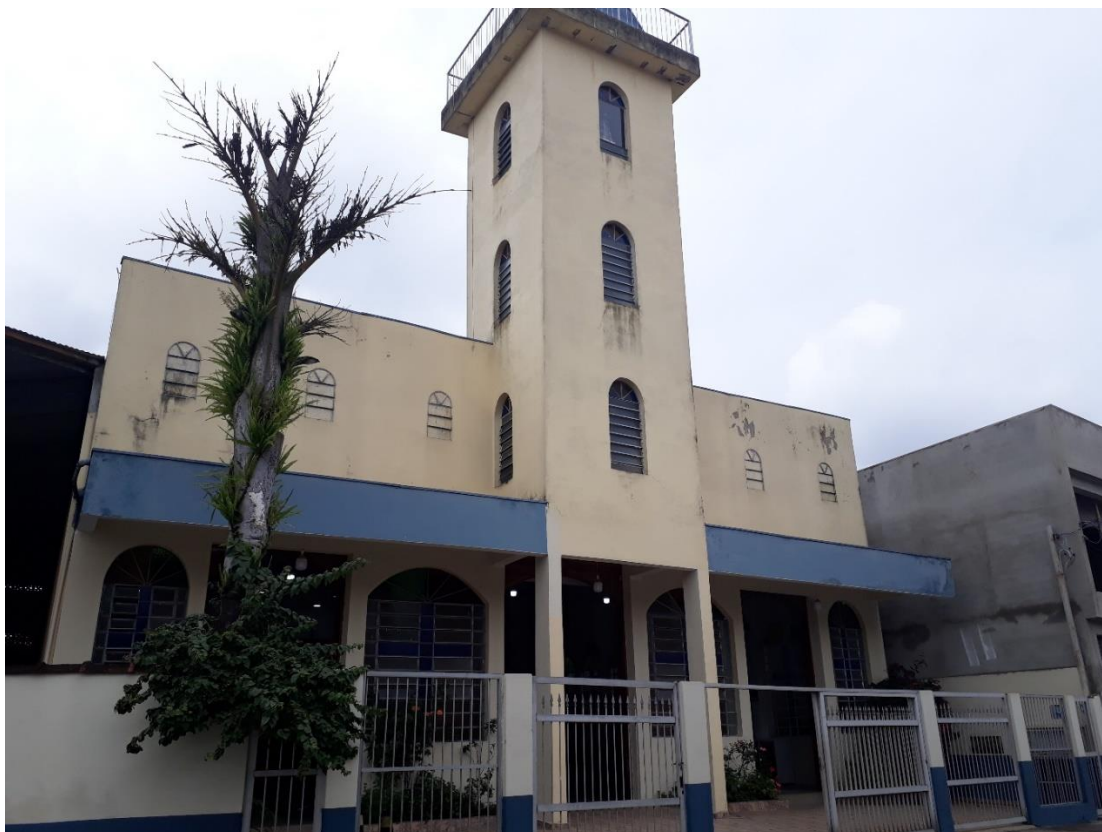
FIGURA 4 – Capela Nossa Senhora Aparecida, Jardim Jacy, Guarulhos (SP)
