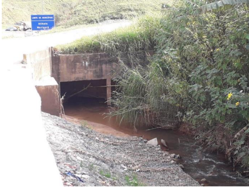
Figura 7 - Travessia da Rodovia Fernão Dias sobre o Rio Jundiá, próximo da divisa entre os municípios de Mairiporã e Atibaia. FONTE: PROFILL (2021).
