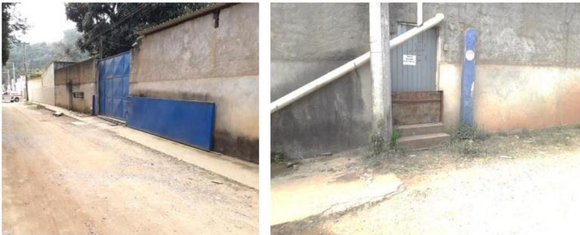
Figura 6 - Ruas do bairro Mil Flores, em Mairiporã, onde são observadas comportas nos acessos.
