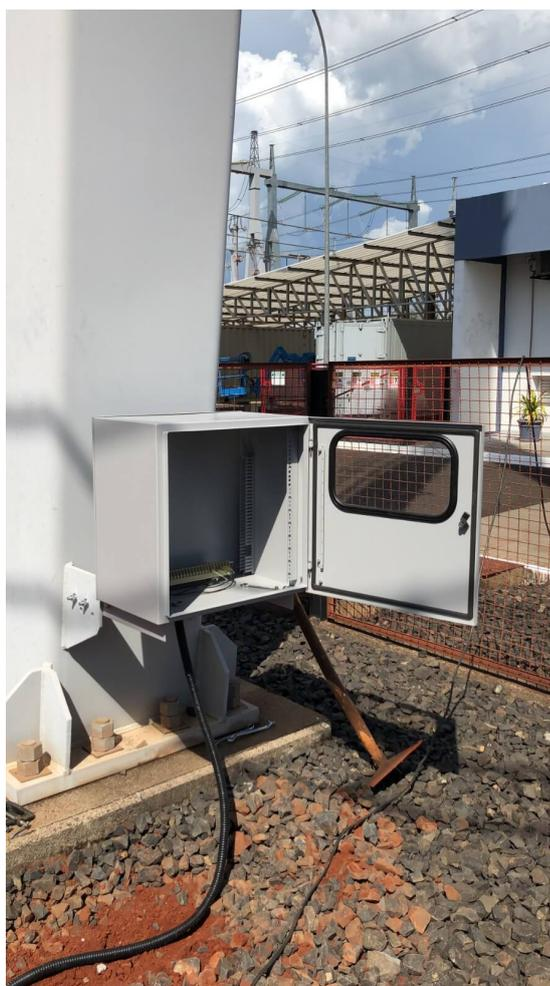
Figura 4.6 – Instalação do NMU-S em rack dentro da área energizada da SE.
