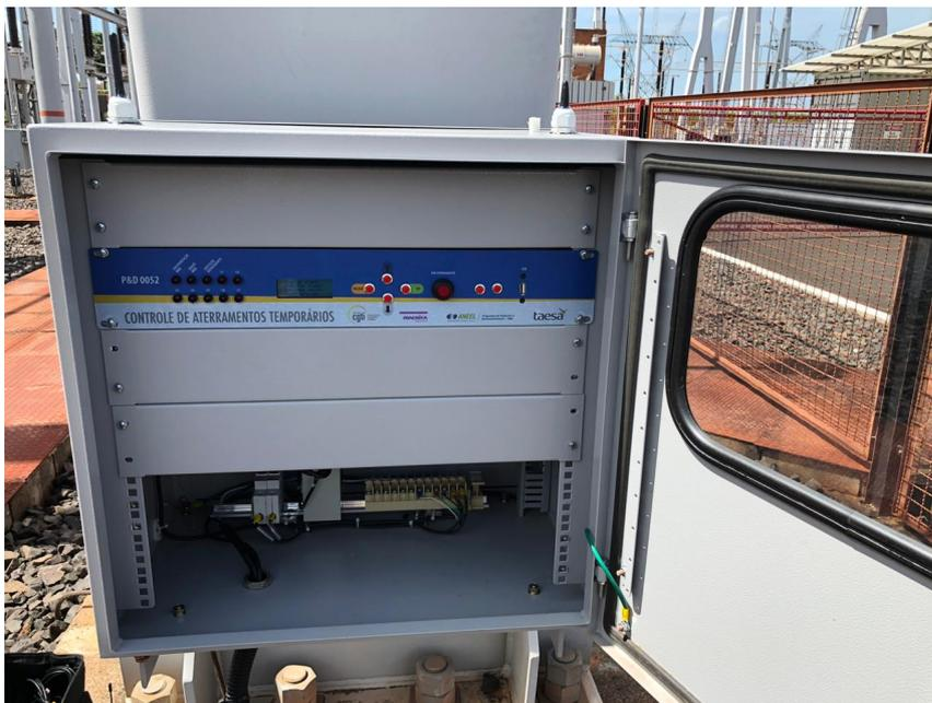
Figura 4.7 – NMU-S instalado em rack dentro da área energizada da SE.
