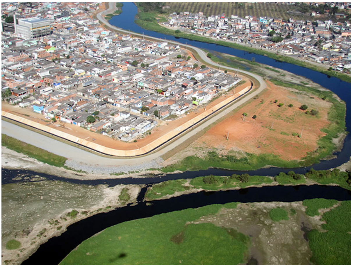
Imagem 46 – Vista área do Jardim Romano, com as obras do dique e do reservatório à esquerda
