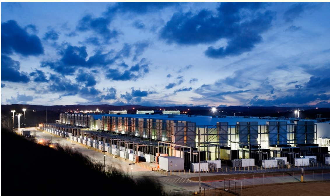
Figura 7 Data Center de Arquitetura Elevada. Atlanta, EUA (2022).
