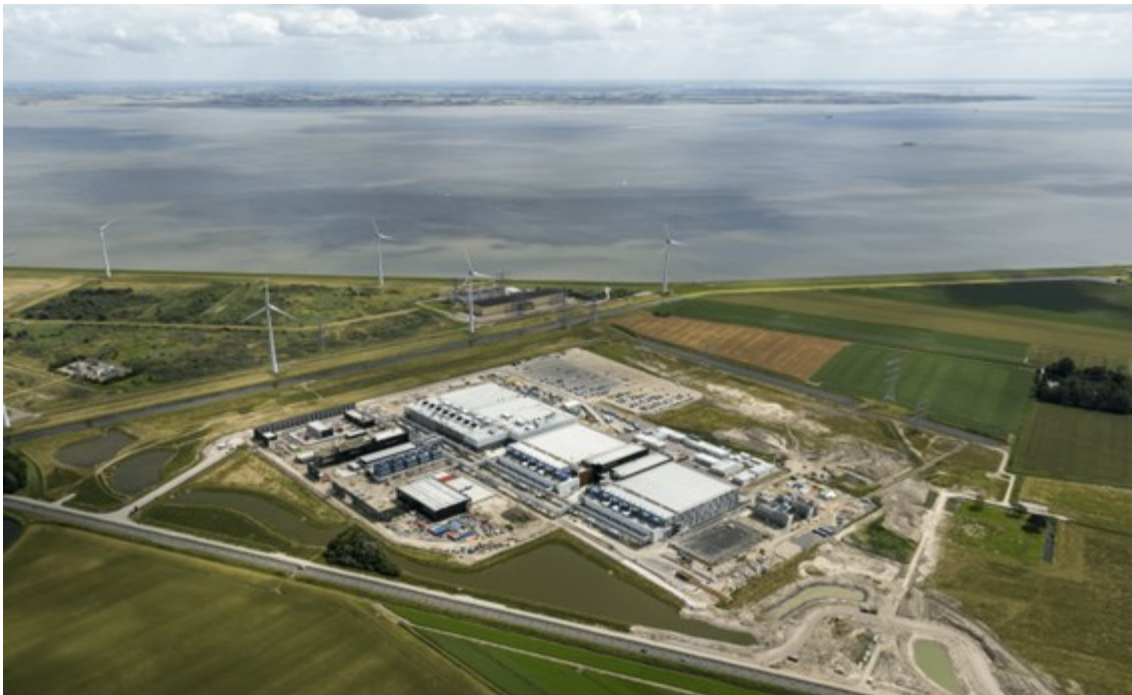
Figura 6 Data Center de Arquitetura Horizontalizada. Países Baixos (2022).
