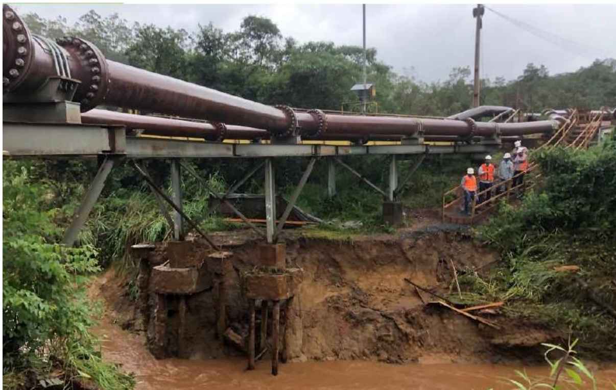
Figura 69: obras de recuperação do pipe rack no Rio dos Peixes, em Nova Lima, MG. Justificando urgência, a empresa iniciou as obras antes do prazo legal de realização de audiência pública para apresentação do projeto. Fonte: ANM, 2023.
