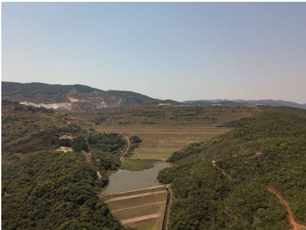
Figura 42: Barragens Sul Inferior (no primeiro plano), Sul Superior (plano intermediário) e Mina do Gongo Soco (ao fundo). Fonte: cortesia de. Júlia Pontes – National Geographic Society
