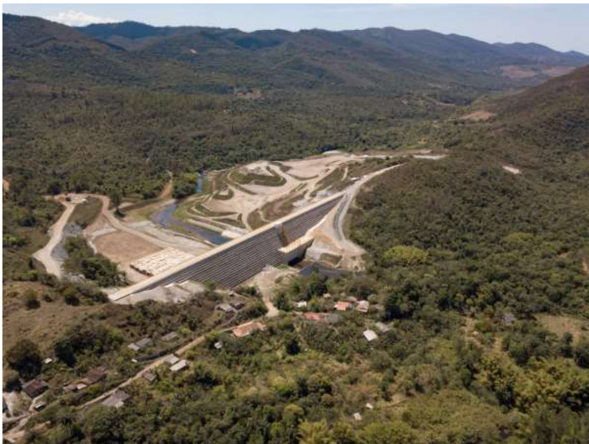
Figura 57: a Estrutura de Contenção a Jusante (ECJ) de Barão de Cocais em, 2020, e a comunidade de Tabuleiro, removida em fevereiro de 2019. (Foto de Júlia Pontes, National Geographic Society).
