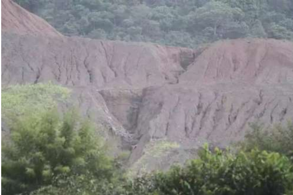
Figura 17: Grandes fendas de erosão observadas na pilha Sapê, de rejeitos de mineração de Ouro da Anglo gold Ashanti em Santa Bárbara, MG (fonte: PARREIRAS, 2022b.)
