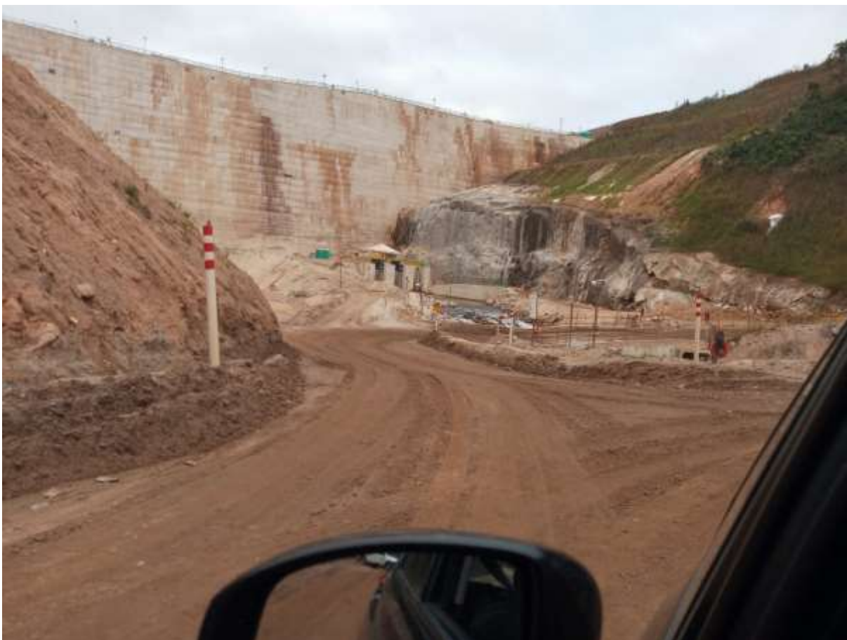
Figura 54: o muro da Vale, em São Gonçalo do Baçõ, em Itabirito, em outubro de 2020, Fonte: o autor.
