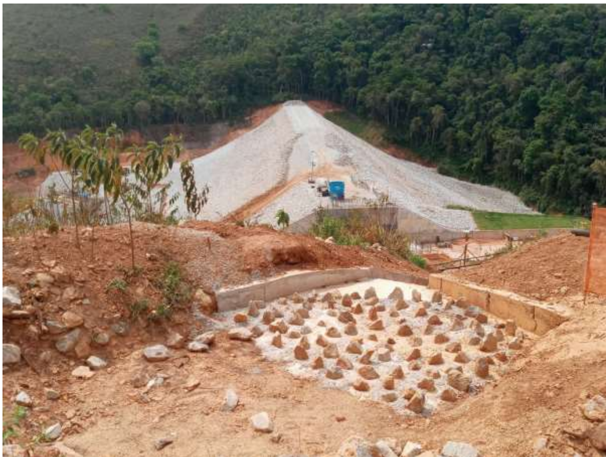
Figura 52: Muro da Vale em Macacos (São Sebastião das Águas Claras, em Nova Lima. Fonte: o autor)
