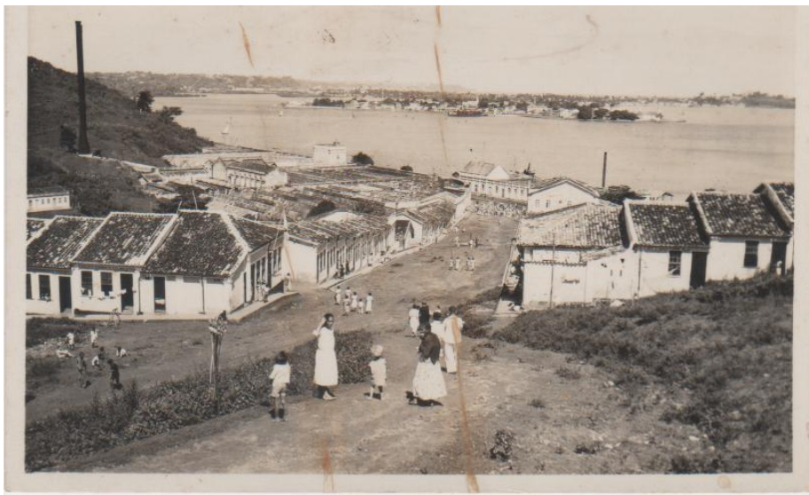
Imagem 17. Vista da Rua de Plataforma, no fim dela é possível avistar a fábrica São Braz e, do outro lado do mar, vê-se o Largo Ribeira, em Itapagipe, s/d. Acervo do Instituto Feminino da Bahia.
