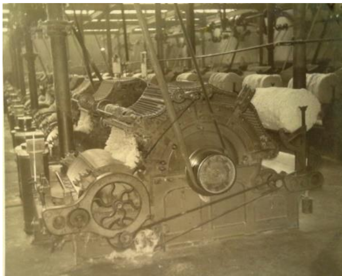
Imagem 20. Fotografia das máquinas de cardar Howard & Bullough da Boa Viagem. A legenda da foto informa: “Funcionaram de 1893 a 1965”. CEDOC/UEFS, FLP, Fundo Luiz Pamponet, cx. 36.
