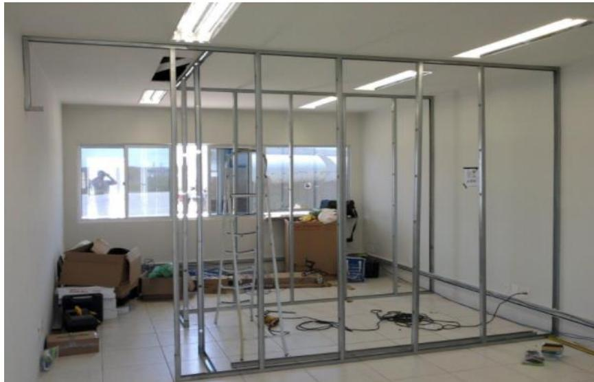
**Figura 6:** Montagem da estrutura metálica
