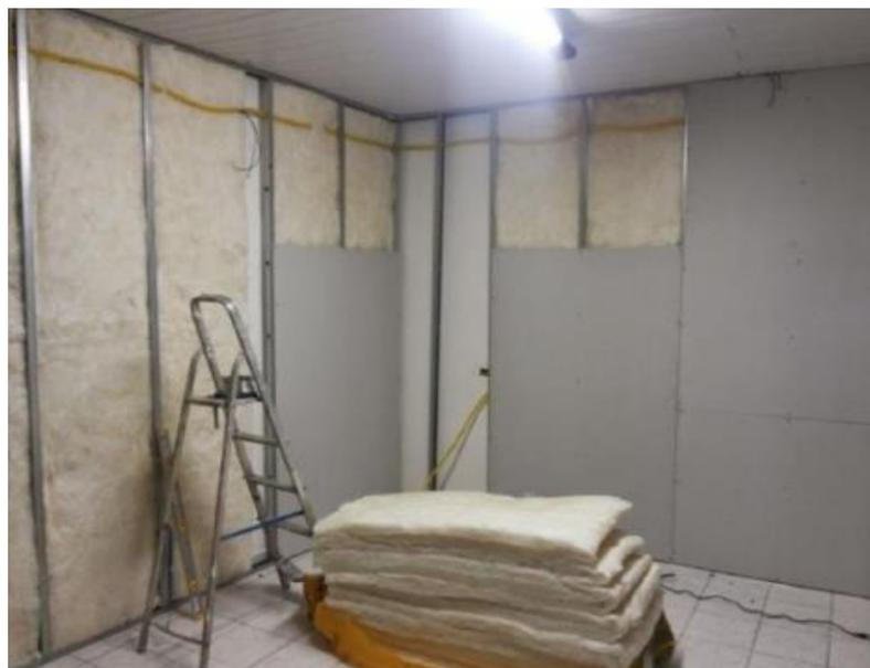
**Figura 7:** Colocação de um dos lados da chapa de gesso acartonado
