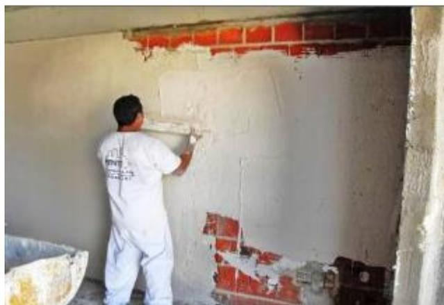
**Figura 10:** Aplicação de gesso manualmente em parede de alvenaria
