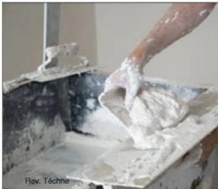
**Figura 9:** Aplicação de gesso manualmente
