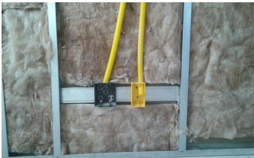
**Figura 8:** Fixação das caixas de derivação
