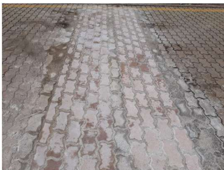
Figura 6b - Pisos intertravados fabricados com água de reúso (à esquerda) e água potável (à direita). (Fonte: o autor)
