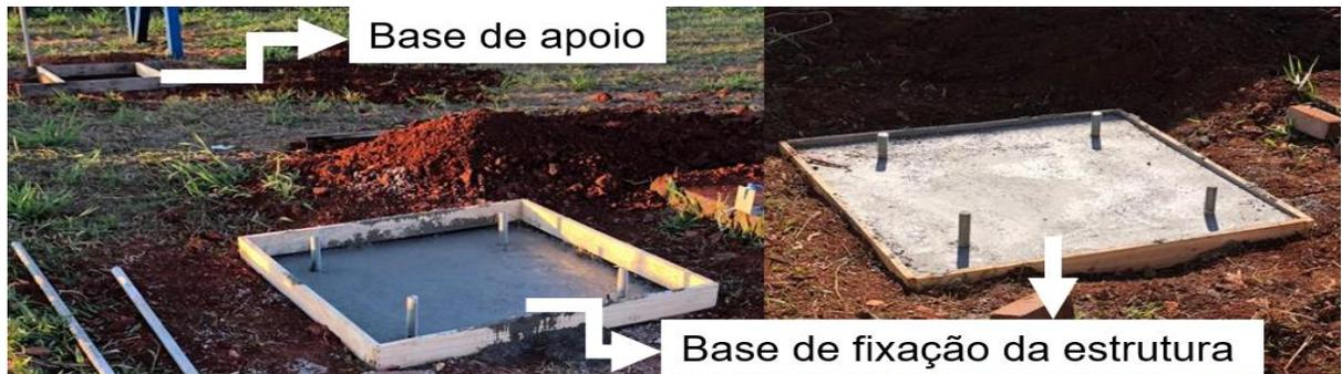
figura 60 - Bases concretadas
