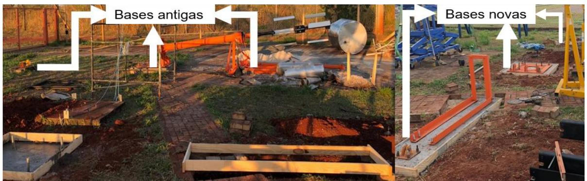
figura 61 – Construção das novas bases para instalação da estrutura
