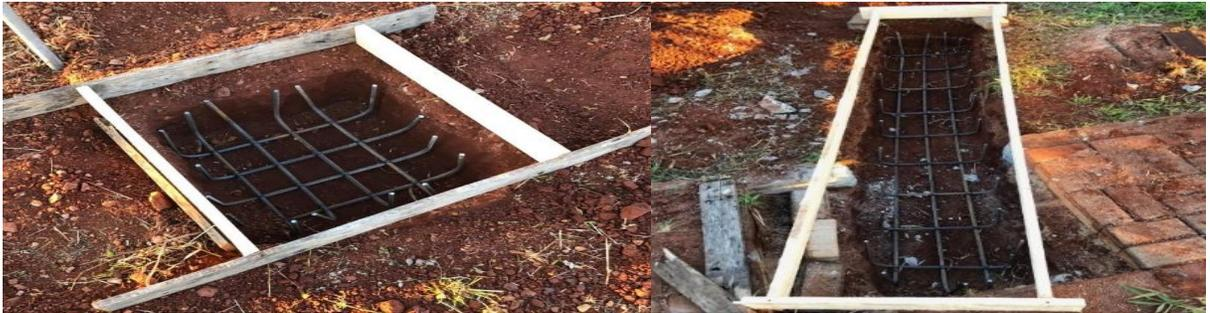
figura 59 - Formas prontas para concretagem
