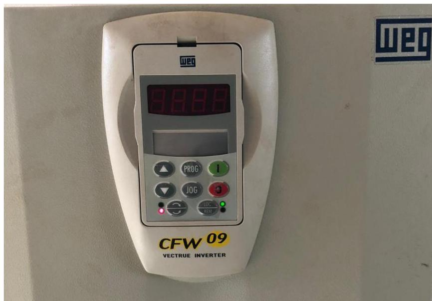
figura 66 - Visor do inversor de frequência do soprador de vento para ajustes na rotação
