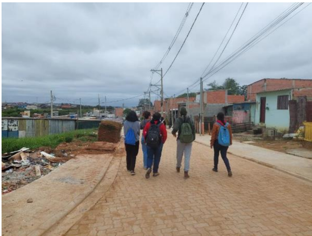
Figura 32: Foto da Rua da União após remoção da “biovaleta” e realização das obras de infraestrutura.
