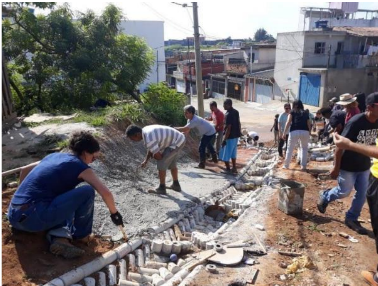
Figura 31: "Biovaleta" sendo construída em regime de mutirão pelos participantes do CPPATHIS, com o e no Jardim da União em 2019.
