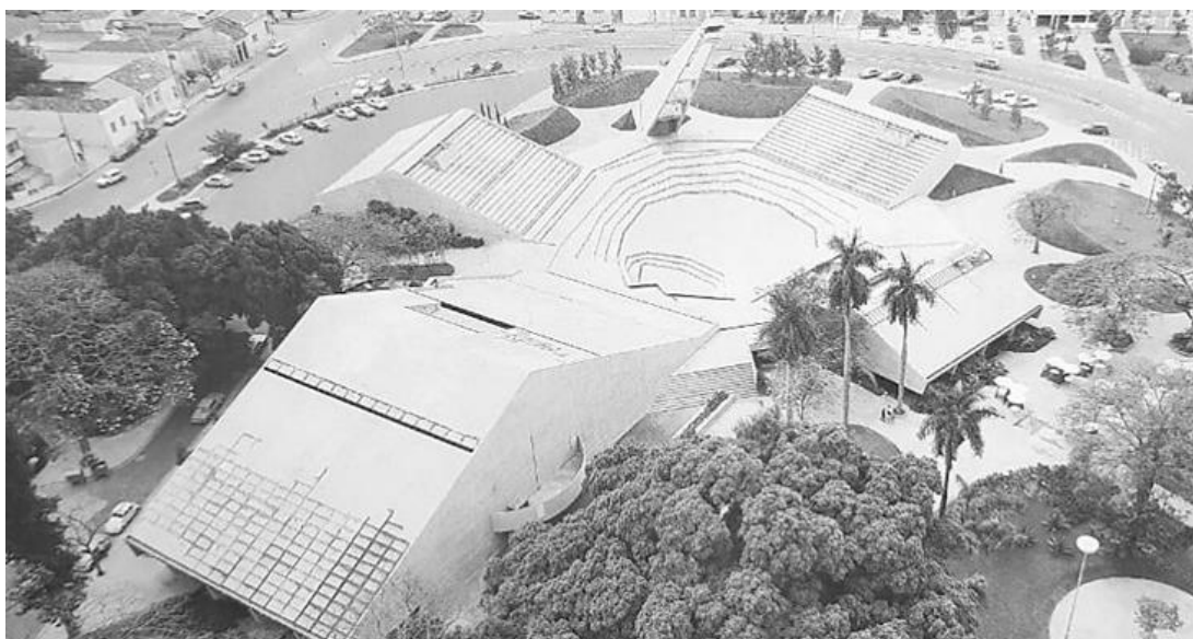
Figura 37 - Centro de Convivência Cultural (1967-1968). Fonte: PENTEADO, 1998, p. 100.
