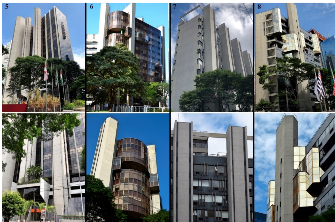
Figura 5 – Fotos dos Edifícios analisados 5) Brasilinterpart (1982-85); 6) João U. Borges (1983-87); 7) Gávea (1985); 8) Haydeé F. de Camargo (1985-89). Fonte: Os autores.
