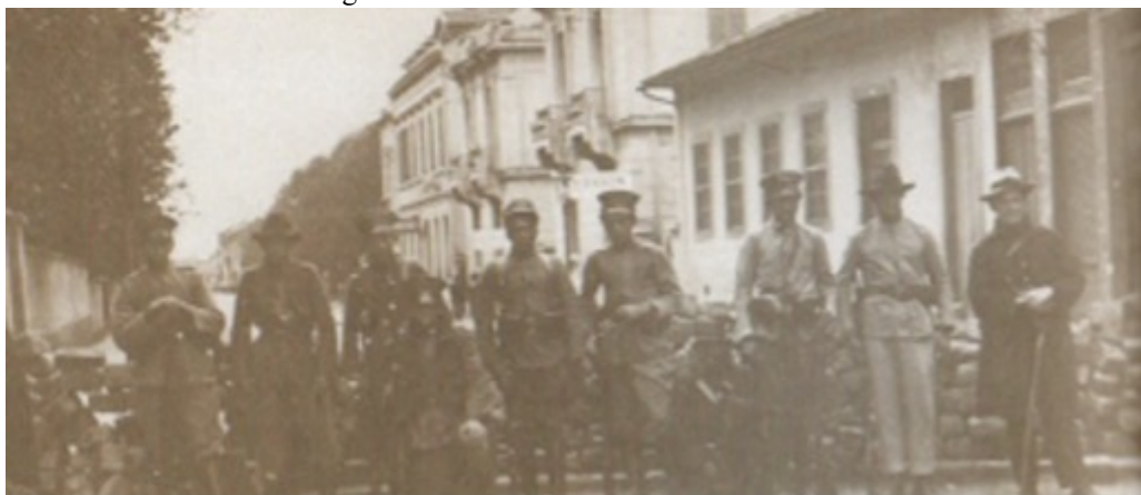
Figura 2.8 – Trincheira na rua Sete de Abril
