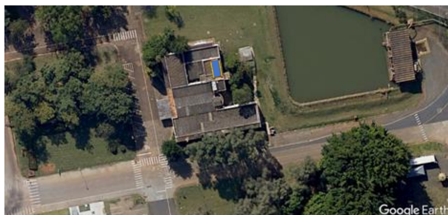
Figura 22. Telhado 4 do Prédio Administrativo da Rhodia. Fonte: Google Earth, 2020.
