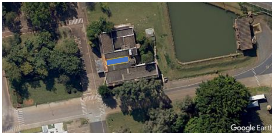
Figura 20. Telhado 2 do Prédio Administrativo da Rhodia. Fonte: Google Earth, 2020.
