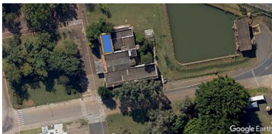
Figura 21. Telhado 3 do Prédio Administrativo da Rhodia. Fonte: Google Earth, 2020.
