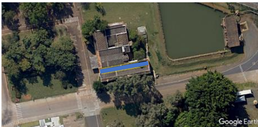
Figura 19. Telhado 1 do Prédio Administrativo da Rhodia. Fonte: Google Earth, 2020.
