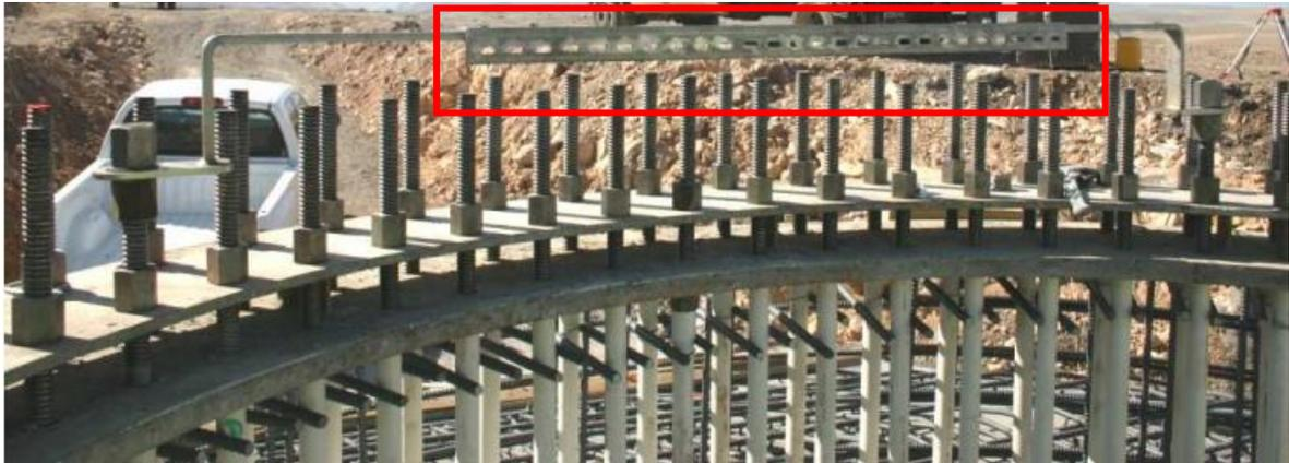
Figura 2.7 – Barra de equipotencialização principal do aerogerador, indicada em vermelho, Fonte: Catálogo Vestas.
