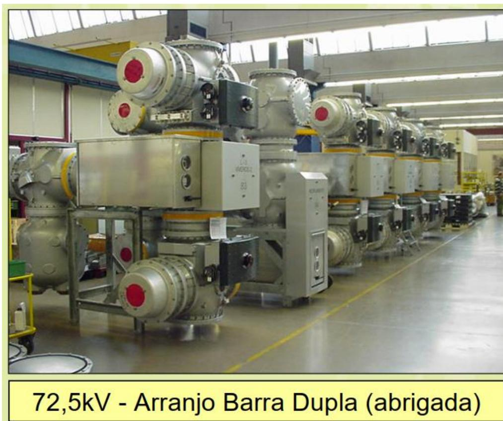
**Figura 4 – Subestação blindada isolada a gás SF<sub>6</sub> (GIS)
