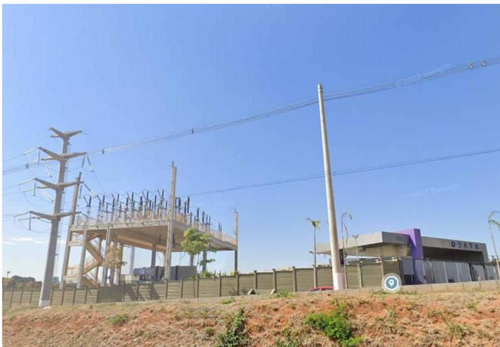
**Figura 17 – Subestação compacta de 138kV ODATA, em Hortolândia-SP, ligada à rede da CPFL, com equipamentos de alta tensão (exceto o transformador) montados sobre uma laje. (Adaptado da Internet, disponível em “Google Maps - StreetView – set. 2021”)**
