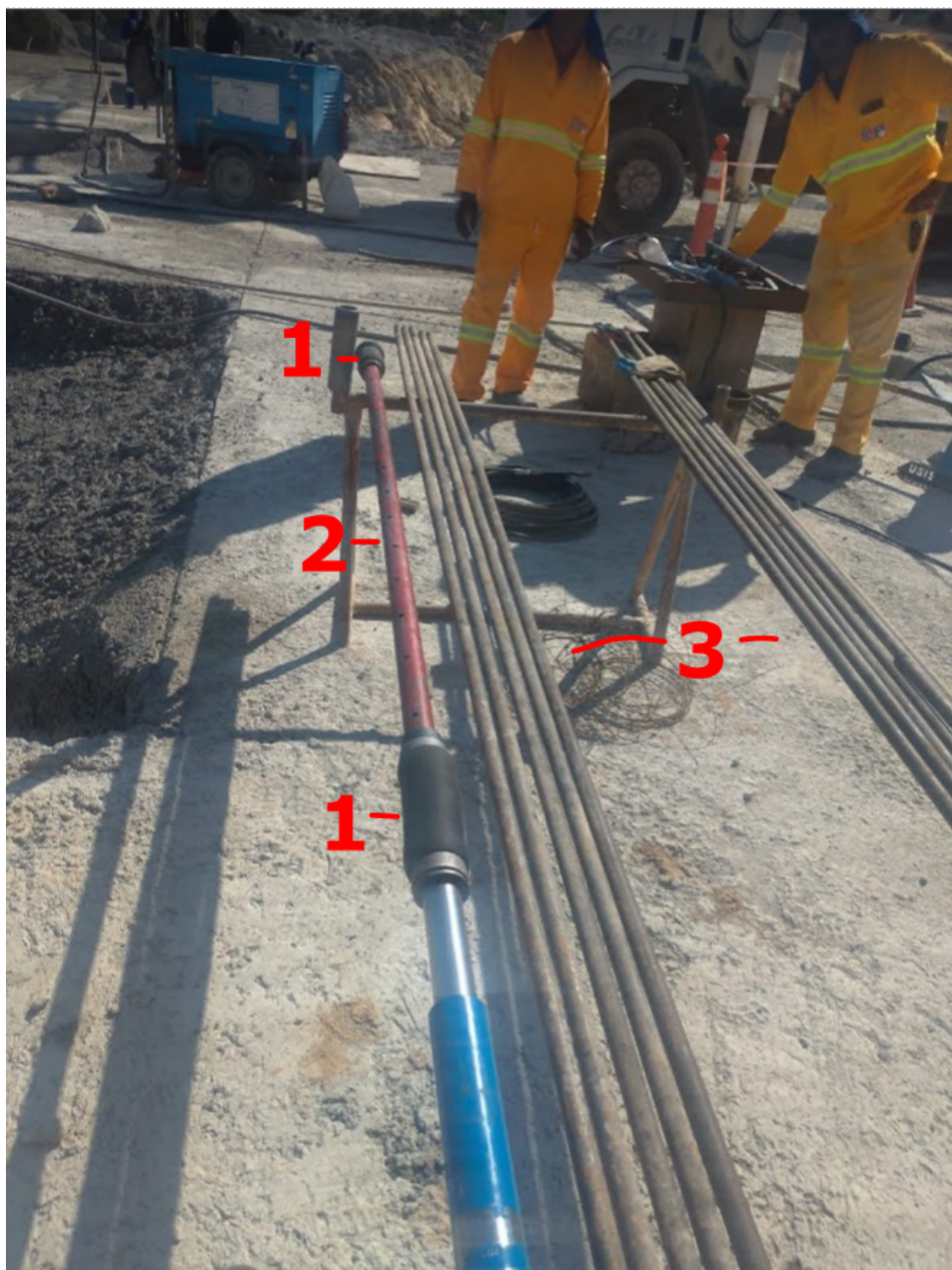
Figura 14 – Foto mostrando os equipamentos de injeção com obturador duplo composta pelos obturadores (1), a "flauta"(2), um tubo com furos por onde a calda sai e as hastes de injeção (3) que descem até o trecho injetado, levando a calda até o trecho pelo seu interior. Nota: os obturadores estão inflados, mostrando como que obstruem os furos empurrando a borracha contra a parede. Fonte: acervo pessoal.
