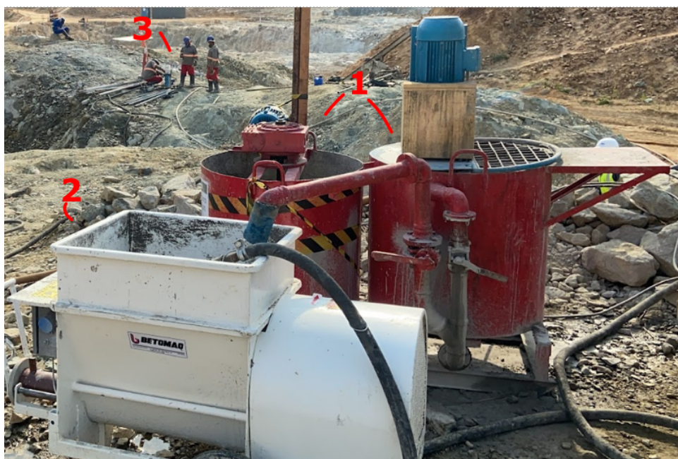
Figura 12 – Foto mostrando o misturador e o agitador de calda (1), junto com a bomba (2). Ao fundo, vê-se a mangueira se conectando às hastes, que descem ao furo vertical (3), onde está ocorrendo a injeção. Fonte: Acervo pessoal.
