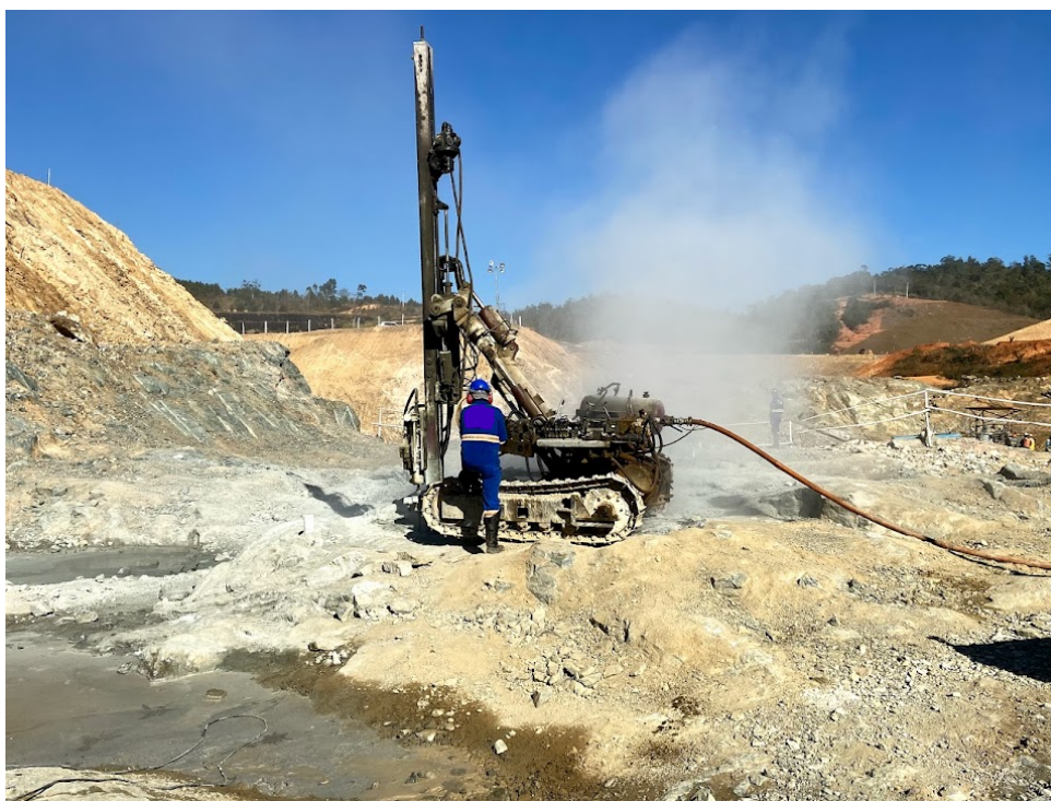
Figura 7 – Foto de uma perfuratriz executando um furo vertical para realização de uma cortina de injeção. Fonte: Acervo pessoal.
