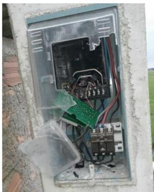
**Figura 2.2: Medidor danificado propositalmente, extraído de [35].**
