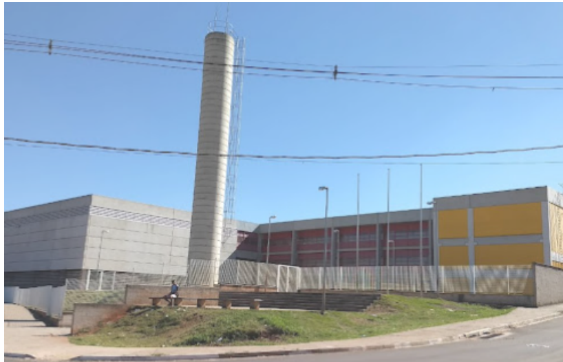
Figura 1 - Fachada da escola 1 (com certificação AQUA). Fonte: Google Maps.
