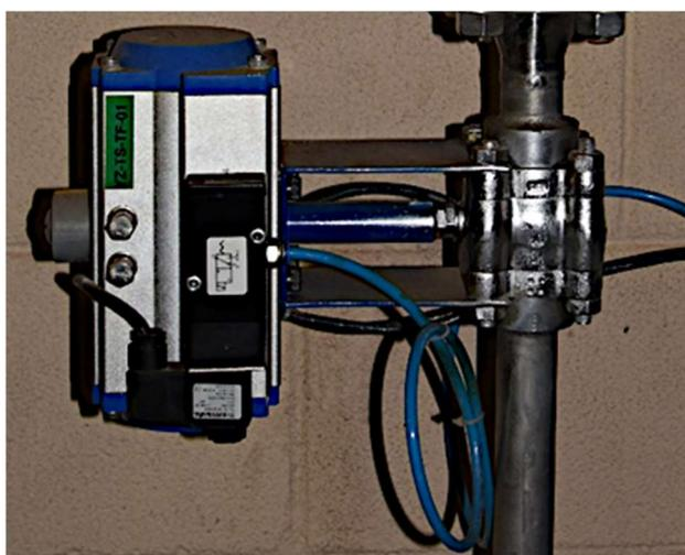
Figura 3.8 - Válvula de fechamento rápido na seção de teste.
