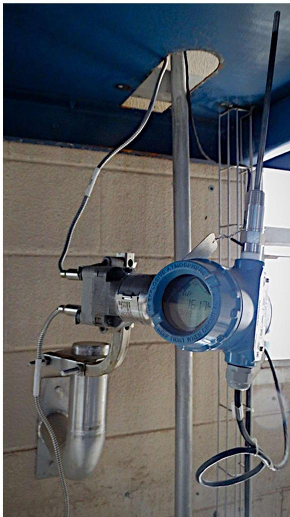
Figura 3.9 – Medidor de Pressão Absoluta e Diferencial.
