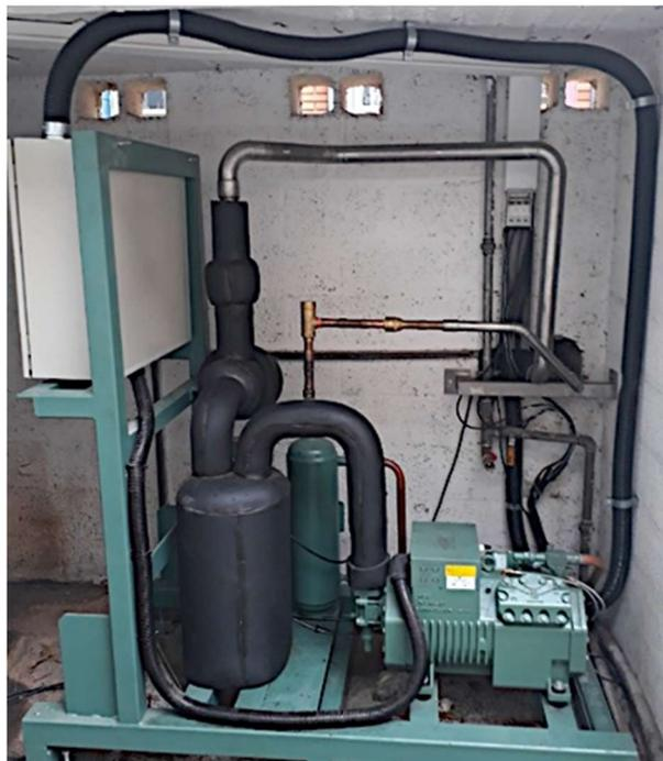
Figura 3.4 - Skid de compressão do ciclo de alta pressão.
