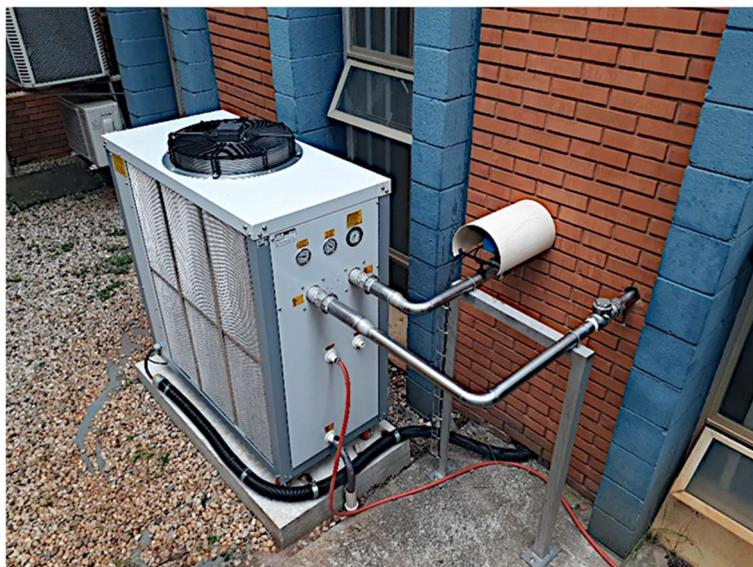
Figura 3.13 – Chiller e Tubulações de Entrada e Saída de Água.
