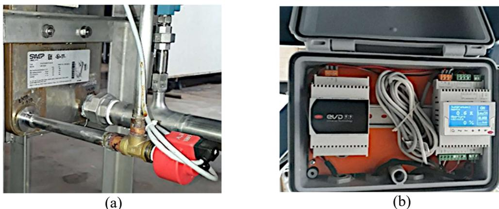
Figura 3.12 - Skid Válvula de expansão: válvula e motor de passo (a); driver da válvula (b).
