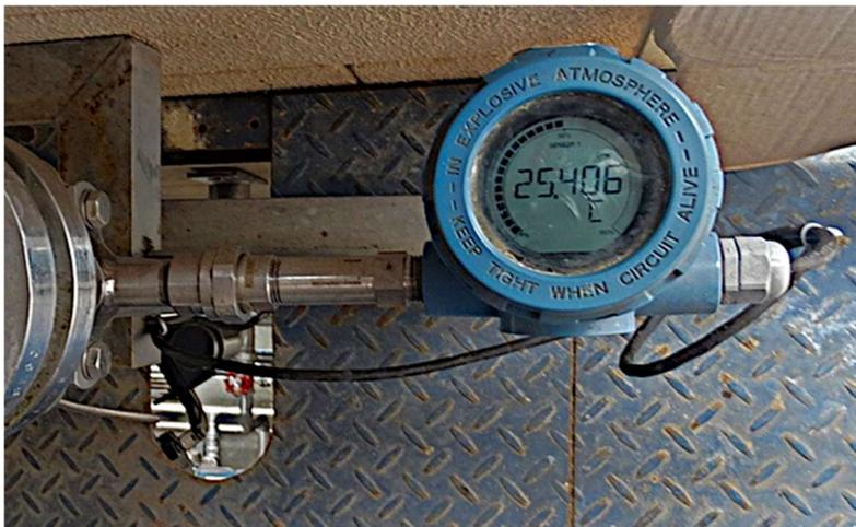
Figura 3.11 – Medidor não intrusivo de temperatura.
