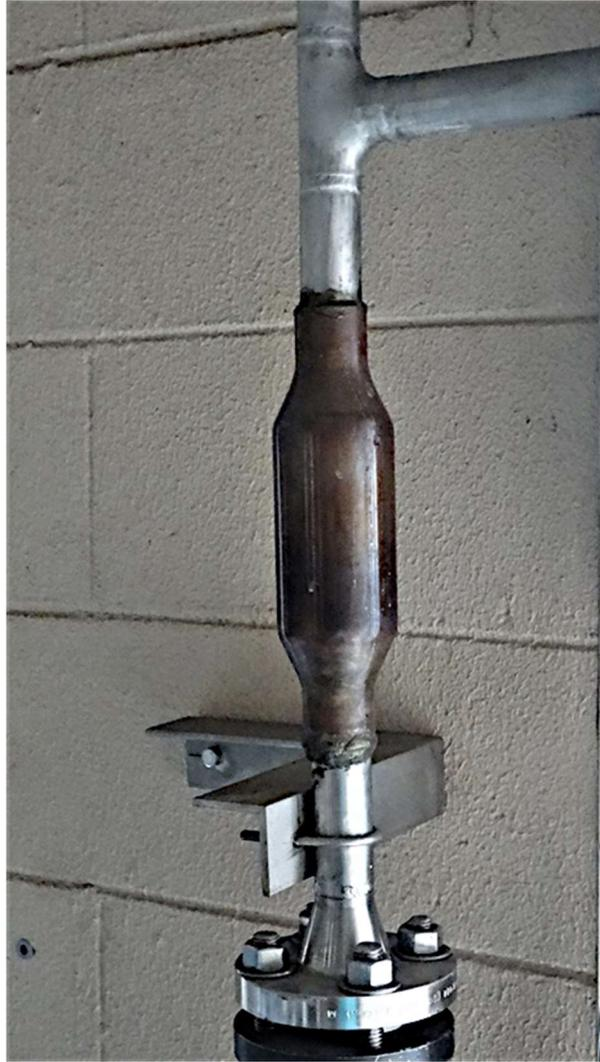
Figura D.4 – Válvula de Retenção Magnética.
