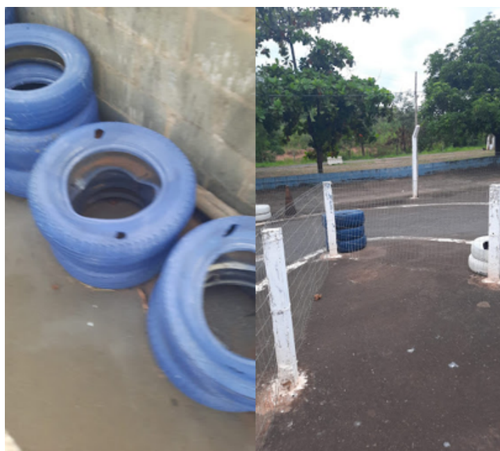
Figura 18 – Estado atual dos pneus e pilar que deve ser realocado
