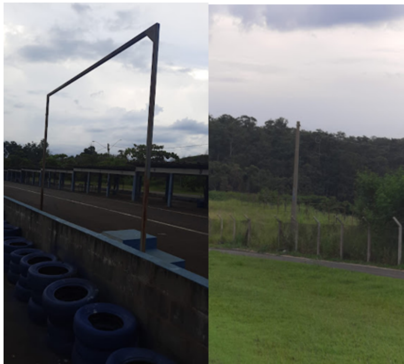
Figura 23 – Reforma do suporte para bandeiras e arquibancadas
