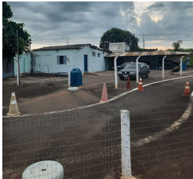
Figura 10 – Casa do caseiro gera necessidade da construção de muros
