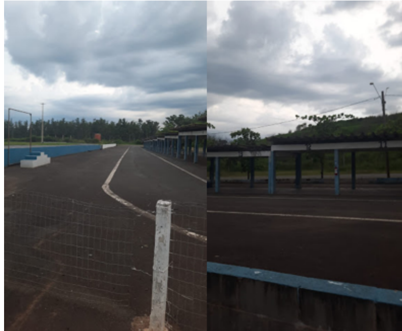
Figura 12 – Estrutura atual dos boxes de apenas um andar
