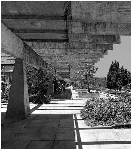
39 Estrutura-arquitetura modular seriada, em concreto aparente
