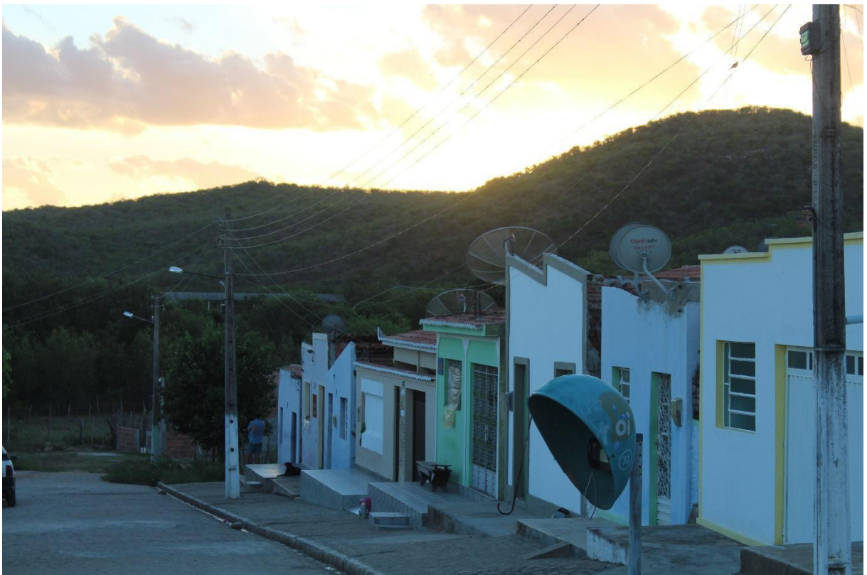
Figura 8 - Destaque para fiação elétrica exposta e antenas parabólicas
