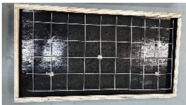
Figura 24: Preparo do arranjo para concretagem do substrato padrão, composto pela forma de madeira (50x25cm) e malha metálica.
