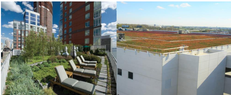
Figura 2: Exemplos de cobertura intensiva (esquerda) e extensiva (direita).
