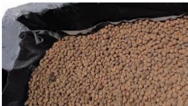
Figura 8: Camada de drenagem, com argila expandida.
