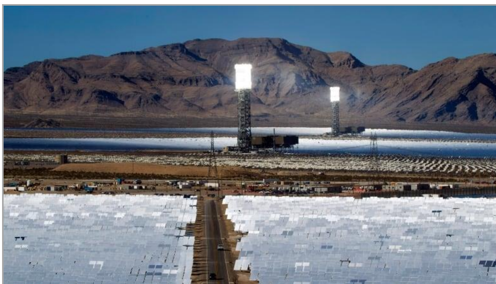
Figura 8: Sistema Gerador Solar Elétrico Ivanpah.
