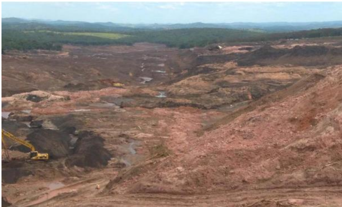
FIGURA 5 – Visão do caminho do rejeito após o rompimento da B I, a partir da crista da B VI
