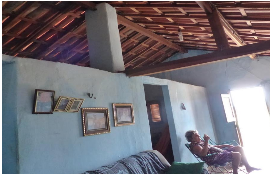
Figura 9. Casa na área rural de Marcelino Vieira, RN rebocada e teto sem forro
