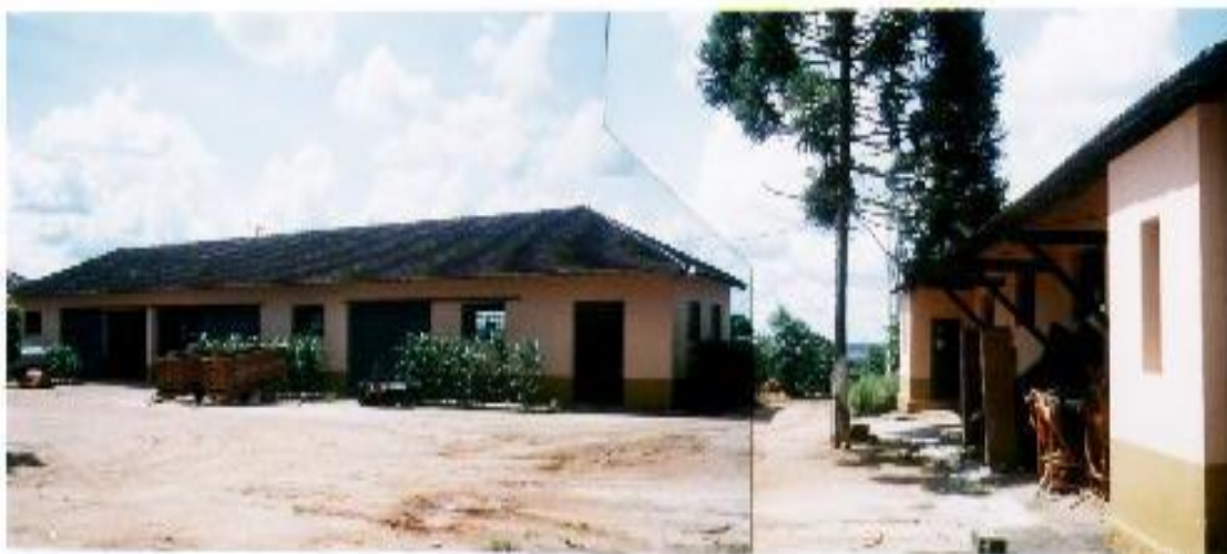
FOTOS 21 e 22 - VISTA INTERNA DAS OFICINAS
