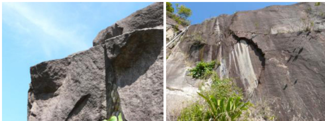
Figura 23. Rugosidades típicas das discontinuidades do maciço
