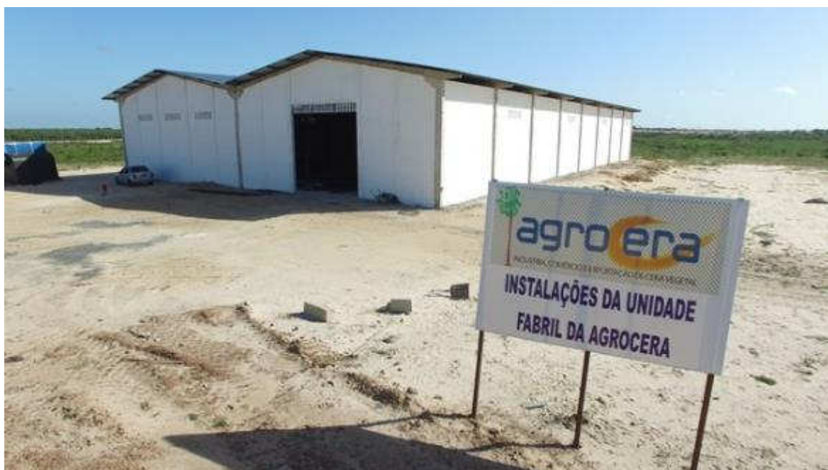
Figura 8 – Barracão da Agrocera na ZPE Parnaíba. Fonte: Portal Costa Norte, 2015.
