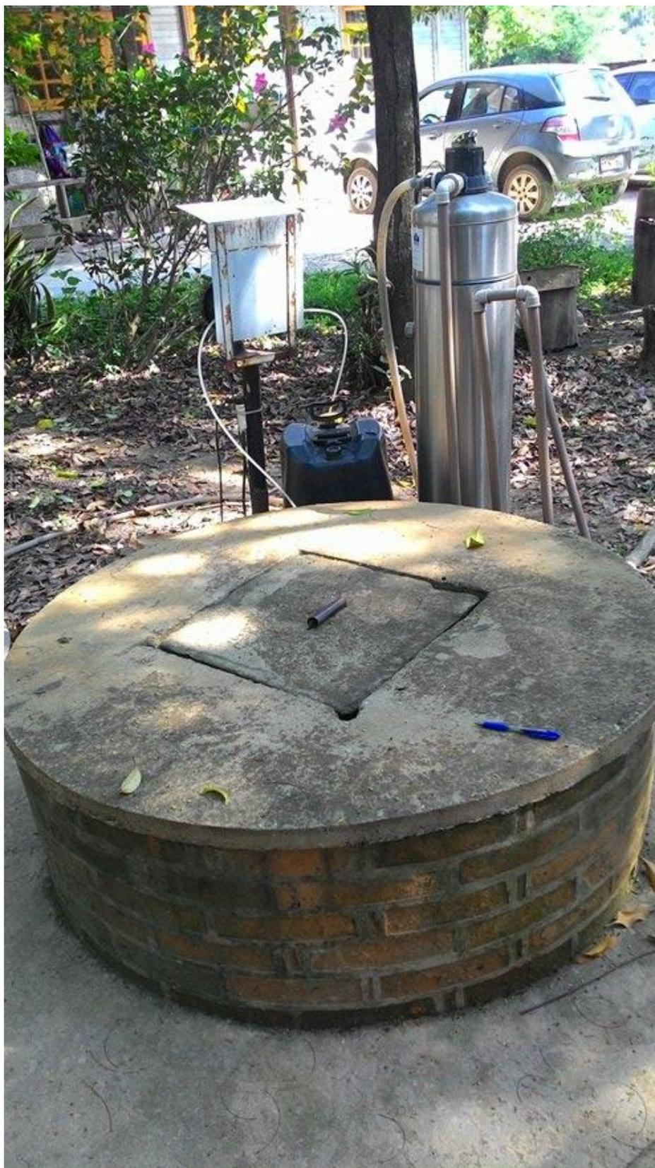
**Figura 5:** Poço doméstico construído com zimbra de concreto, alvenaria na altura de 50 cm e laje de proteção.
