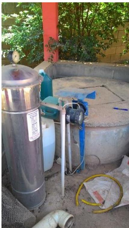
**Figura 6:** Poço doméstico construído com zimbra de concreto e laje de proteção.
