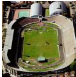
Figura 18 - Vista aérea atual do Estádio Barão da Serra Negra Fonte: www.geocities.com
