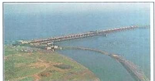
Jupiá. Usina Concluída em 1974. As obras da eclusa, iniciadas em 1998, já foram concluídas.
