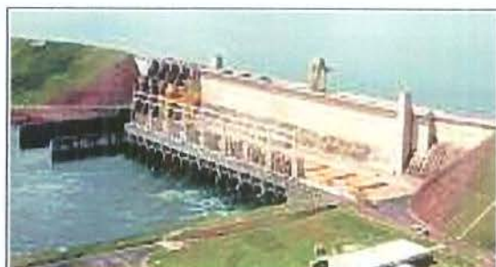
Três Irmãos. Concluída em 1991. É a maior usina do Rio Tietê.
