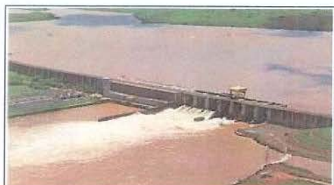
Usina de Ititinga, concluída em 1969, navegável desde 1986.
